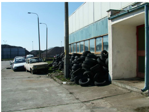
Nieprawidłowe składowanie opon – brak środków gaśniczych
